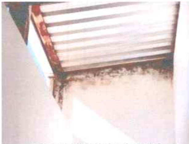
ESCADA DE ACESSO AO 2º PAVIMENTO
