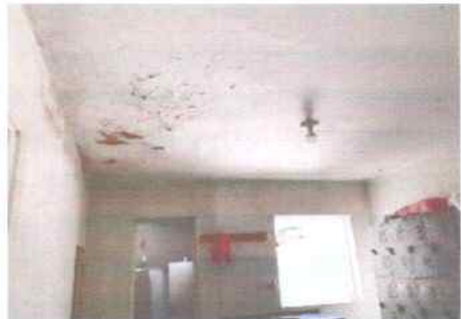
DESCANSO/VESTIÁRIO DE FUNCIONÁRIOS 2º PAVIMENTO
