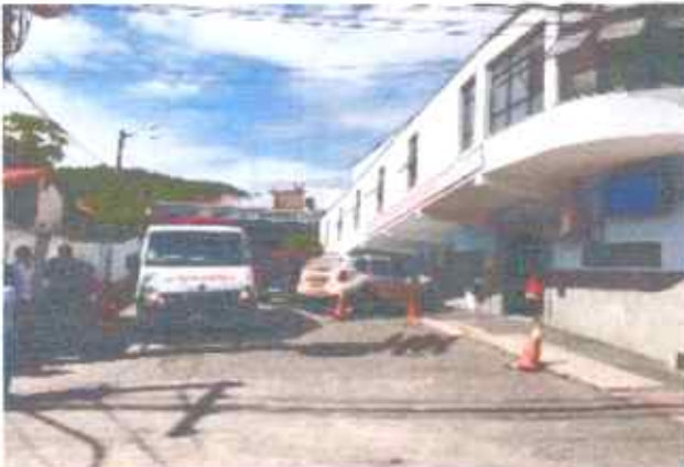
FACHADA RUA ABEL V. R. DE MORAES
