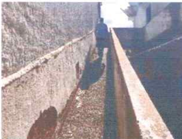
RAMPA DE ACESSO AO TELHADO
