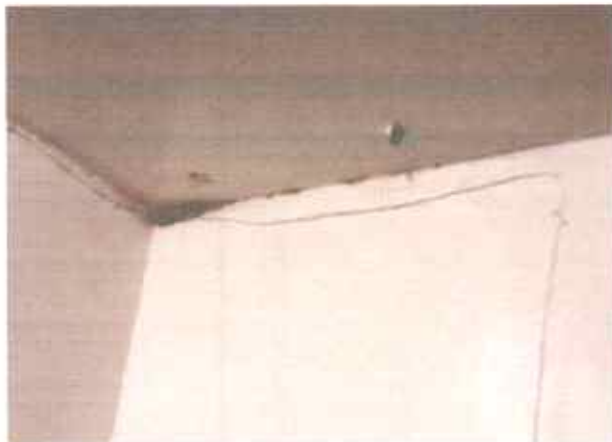
PAREDE AO LADO DA VIGA CORTADA
