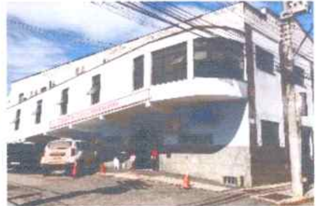
FACHADA RUA ABEL V. R. DE MORAES
