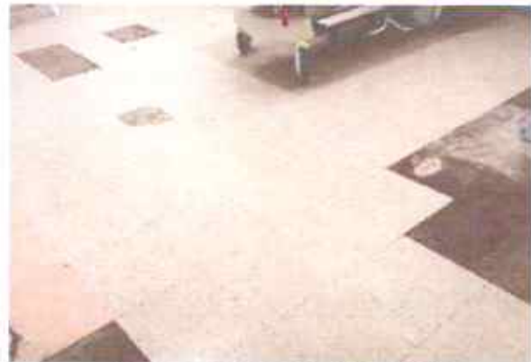
PISO DA SALA DE OBSERVAÇÃO
