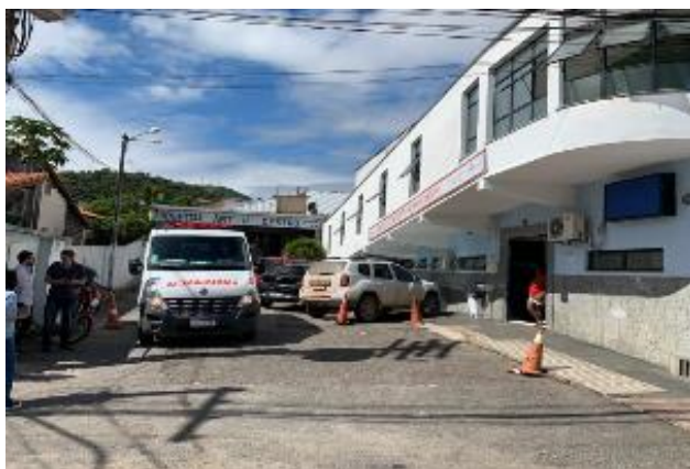
FACHADA RUA ABEL V. R. DE MORAES
