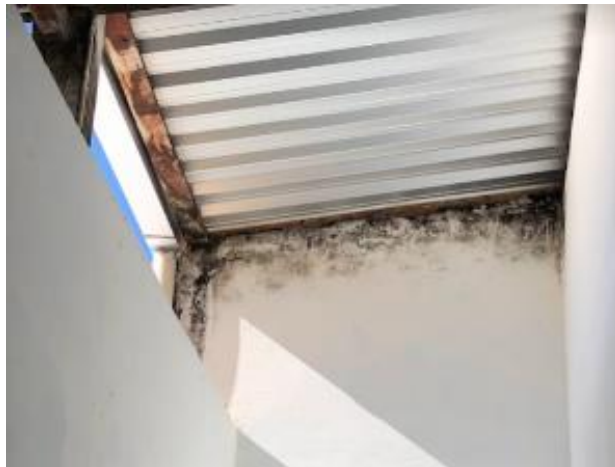
ESCADA DE ACESSO AO 2º PAVIMENTO
