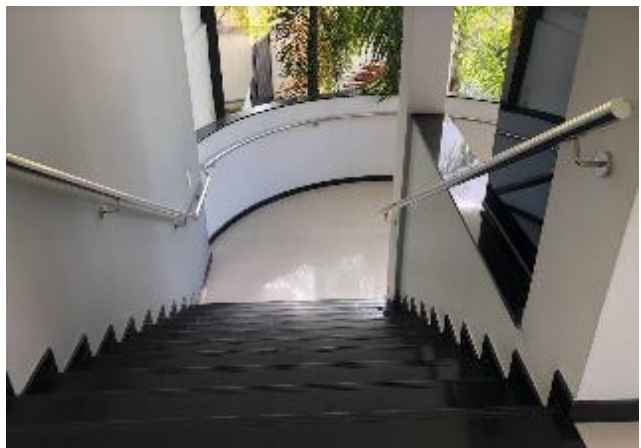
ESCADA DE ACESSO A CLÍMAX
