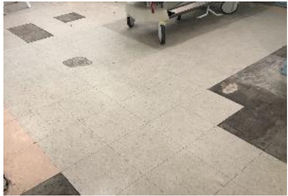
PISO DA SALA DE OBSERVAÇÃO
