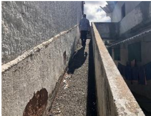
RAMPA DE ACESSO AO TELHADO
