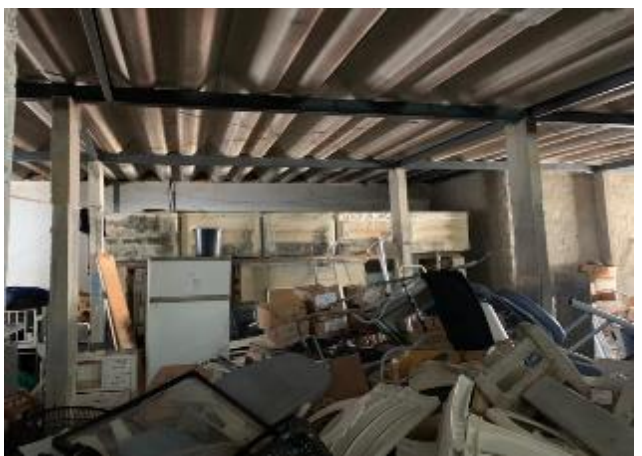
ESCADA DE ACESSO AO 2º PAVIMENTO
