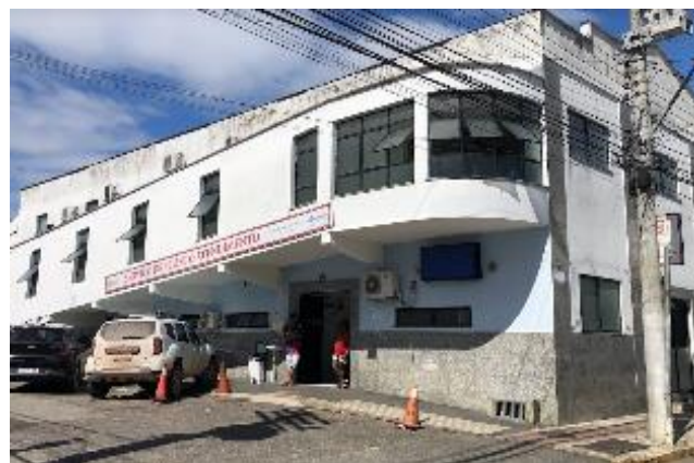
FACHADA RUA ABEL V. R. DE MORAES
